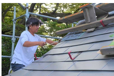
難しい葺甲のせり上げ
